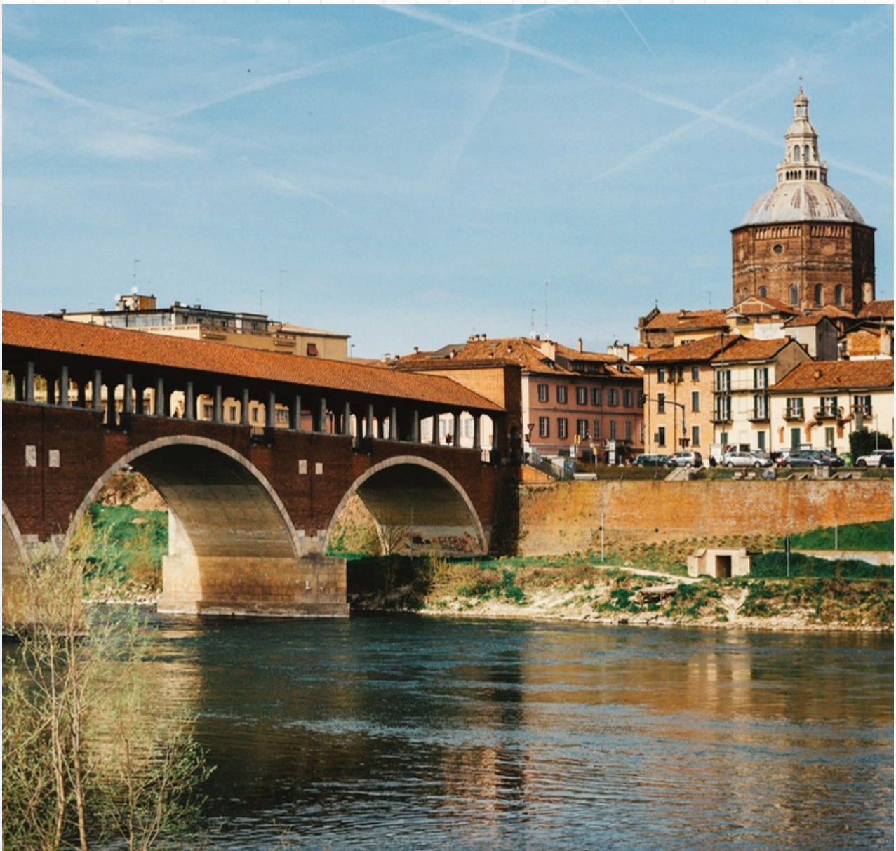
Ponte coperto, Pavia.
