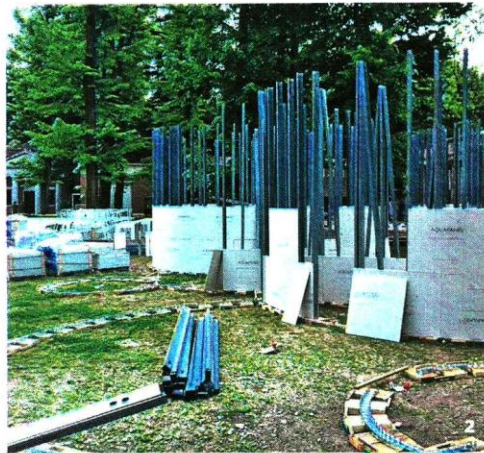
1 Anillados. Diez figuras cilíndricas entrelazadas proponen un recorrido lúdico y cambiante. 2 Construcción. Se atornillaron más de 400 perfiles de acero cada 40 centímetros.
